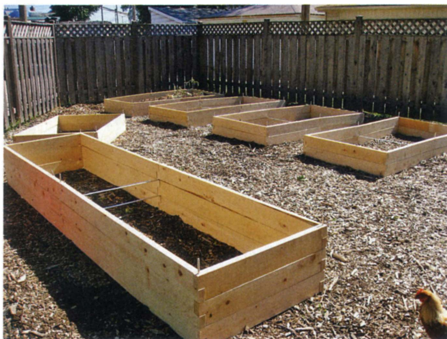
Если используются доски толщиной 40–50 мм, их соединяют в углах встык или вполдерева. Продольные стороны каркаса дополнительно укрепляют по центру поперечными стяжками из брусков или металлического профиля.
