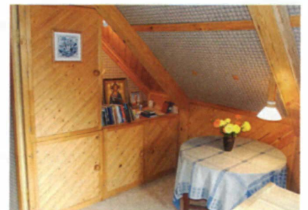
Комбинированный шкаф, который стал частью перегородки между комнатами, очень пригодился в спальне. Его дверки отделаны вагонкой и деревянным уголком.
