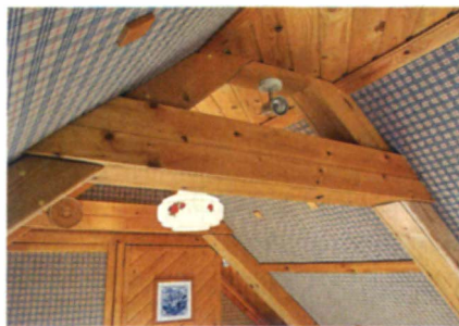
Потолок, часть фронтовых стен, стропил и ригелей облицованы вагонкой.
