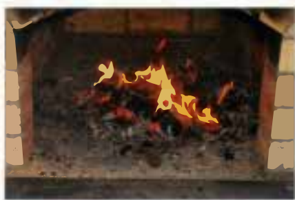
Рано закрытая задвижка в печи — самая частая причина отравления угарным газом.
